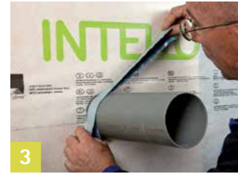
3 Nalepit na trubku Pásku nasadte na trubku a postupně ji na ní po obvodu přilepte. Dbejte na dostatečný lepený přesah konců pásky.
