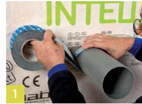
1 Odměřit pásku Rozviňte pásku v potřebné délce a ustříhnete.
