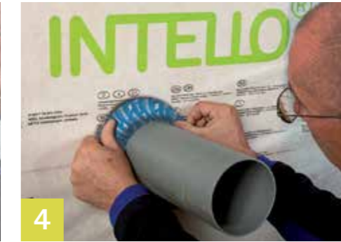
4 Nalepit na plochu Zcela odstraňte druhou separační fólii. Pásku postupně přehřte na plochu a postupně kolem dokola přilepte.
