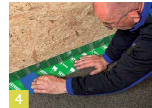
4 Pevně přitlačit Pásku pevně přitlačit na stěnu i podlahu. Obzvláště účinné a pro Vaše ruce šetrné je přitlačení pomocí pomůcky pro clima PRESSFIX.
