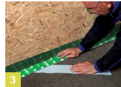
3 Nalepit na podlahu Stáhněte postupně druhou separační fólii a pásku postupně přilepte na podlahu.
