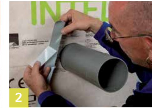
2 Stáhnout první separační fólii Pásku v prostředku podélně přeložte a stáhněte první separační fólii.
