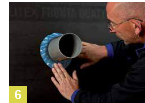
6 Použití též venku Pomocí EXTOSEAL MAGOV lze provést i v exteriéru bezpečné napojení prostupujících dílů na opláštění stěn, pásovin pro použití se záklopem i bez záklopu, jakož i na deskové materiály.
