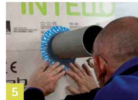
5 Pevně přitlačit Pásku následně všude pevně přitlačte. Dbejte na dostatečný protitlak. Obzvláště účinné a pro Vaše ruce šetrné je přitlačení pomocí pomůcky pro clima PRESSFIX.
