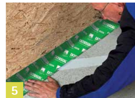
5 Lepení též na podlahu EXTOSEAL FINOC lze lepit též přímo na beton. V případě potřeby podklad napenetrujte základním nátěrem TESCON PRIMER RP.
